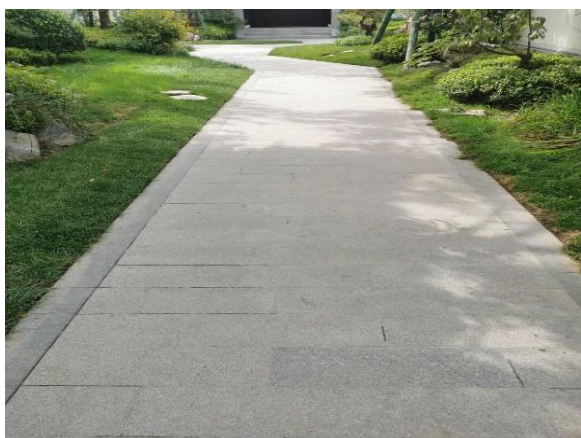
透水铺装工程
