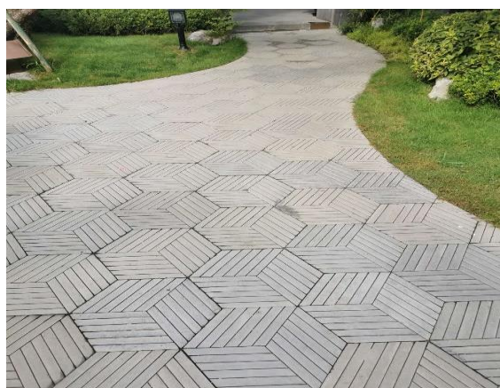
透水铺装工程
