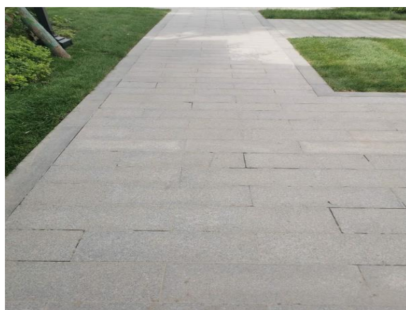
透水铺装工程
