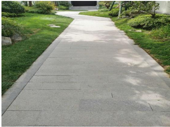
透水铺装工程
