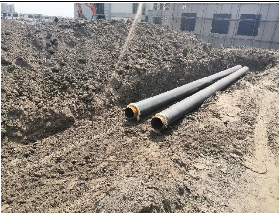
雨水排水工程
