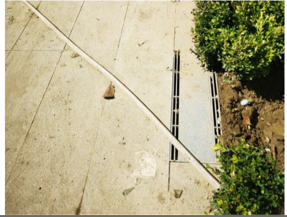
雨水排水工程
