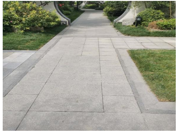
透水铺装工程
