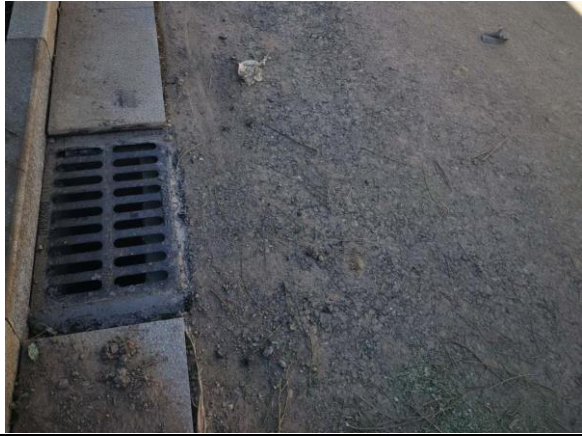
雨水排水工程
