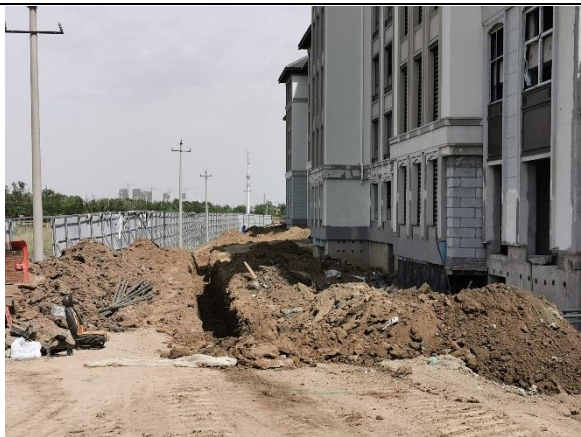
雨水排水工程
