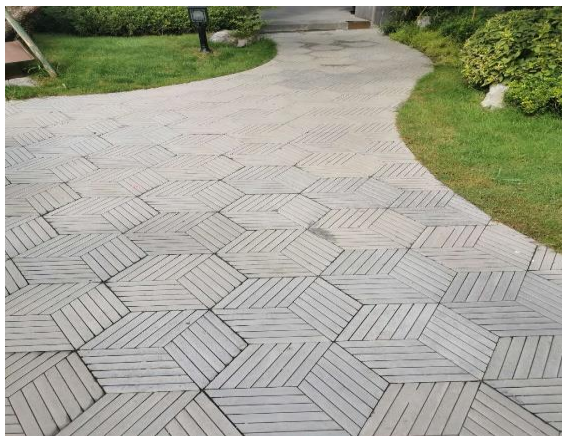
透水铺装工程
