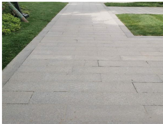
透水铺装工程
