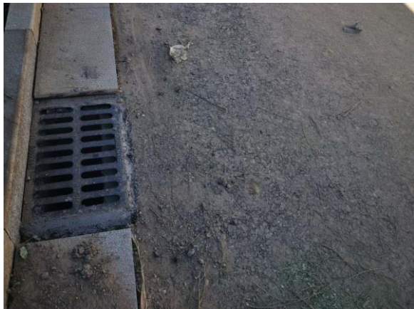
雨水排水工程
