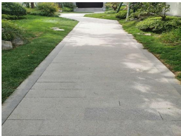
透水铺装工程
