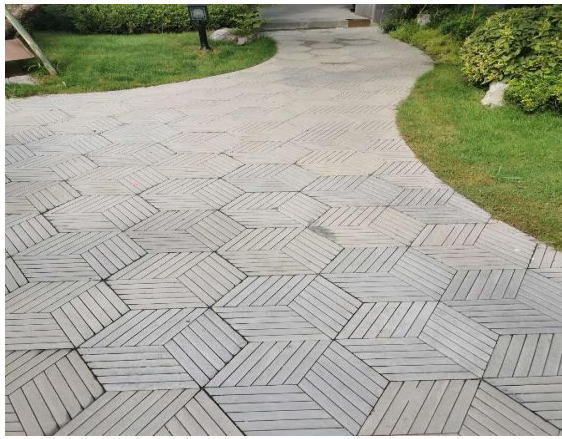
透水铺装工程
