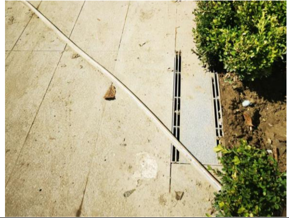
雨水排水工程
