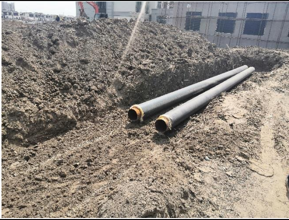
雨水排水工程
