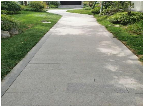
透水铺装工程
