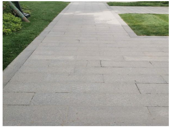
透水铺装工程
